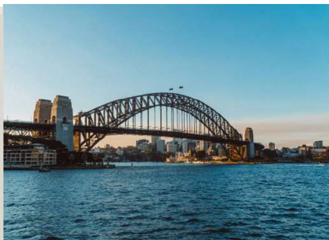
雪梨港灣大橋 Sydney Harbour Bridge
